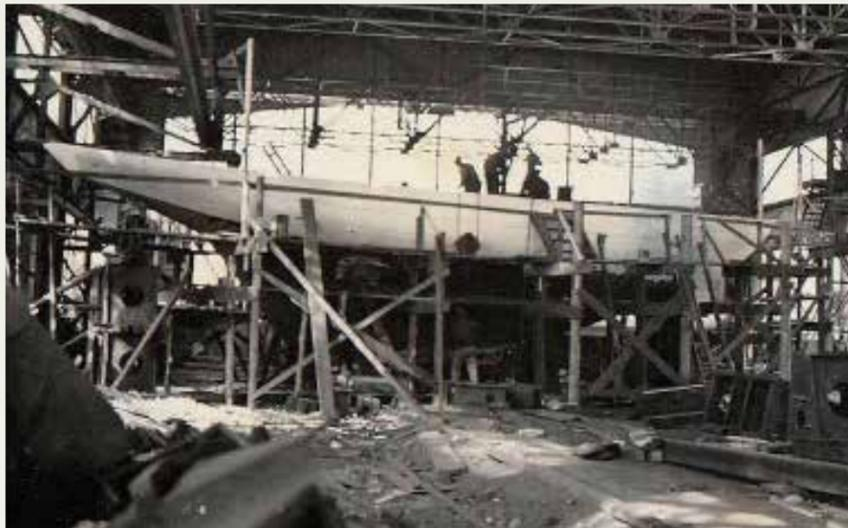
Bau auf der Danziger Werft. Der Rumpf entsteht aus genietetem Stahl; es ist die erste Yacht, die den 1852 gegründeten Betrieb verlässt. Der Ausbau erfolgt von Studenten in Eigenregie
